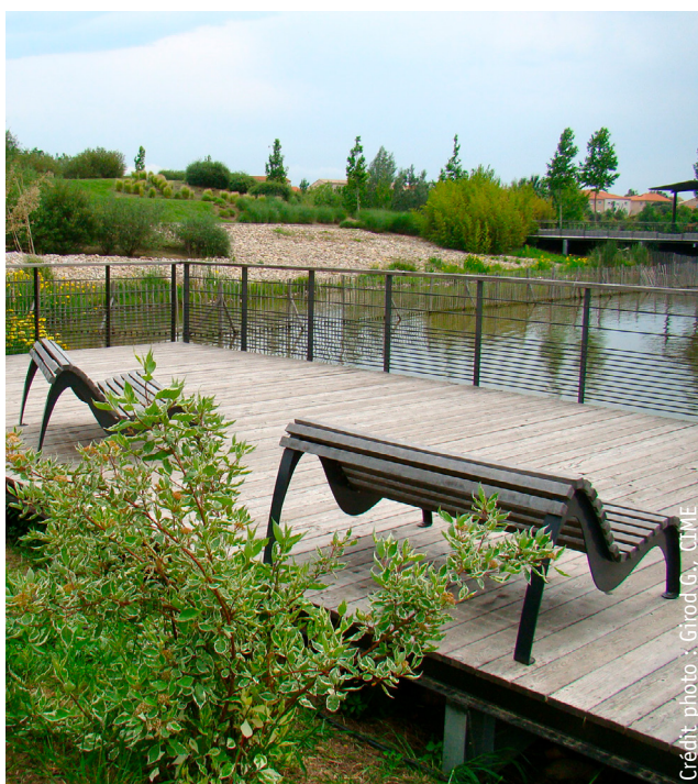
Ponton réalisé en mélèze (bois issu de la filière locale). Parc Sant Vicens, labellisé EcoJardin en 2013, Perpignan (66)
